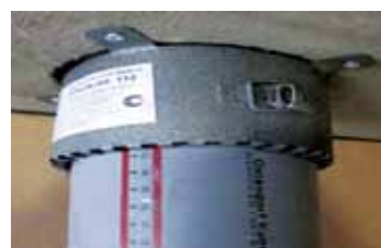
Рис. 50. Противопожарная муфта, закрепленная на трубопроводе
