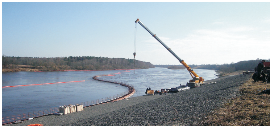
Стационарная технологическая площадка на р. Западная Двина. Момент установки металлических боновых заграждений при ликвидации аварии на магистральном нефтепродуктопроводе «Унеча-Вентспилс» (26.03.2007 г.)
