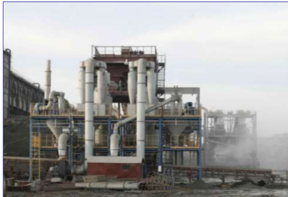
Линия по производству кубовидного щебня на РУПП «Гранит» (г. Микашевичи), оборудованная комплексом производства НПО «Центр»
