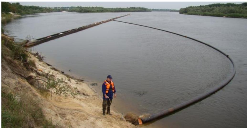
Рисунок 2 – Установка боновых заграждений на стационарном рубеже №1 (н.п. Луначарск)
