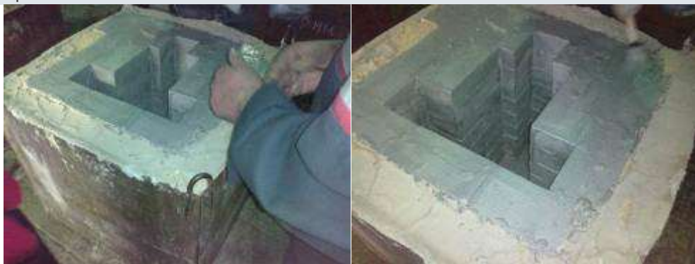
ОАО «Минский моторный завод». Соляная ванна для термической обработки металлов с нанесенным покрытием
