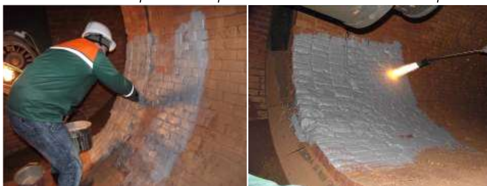
ОАО «Завод керамзитового гравия», г. Новолукомль. Вращающаяся печь для обжига керамзита, опытное нанесение покрытия
