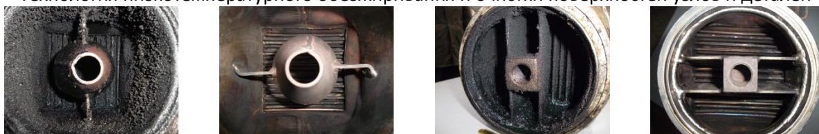
Внешний вид котла подогревателя: а, в — до очистки; б, з — после очистки
