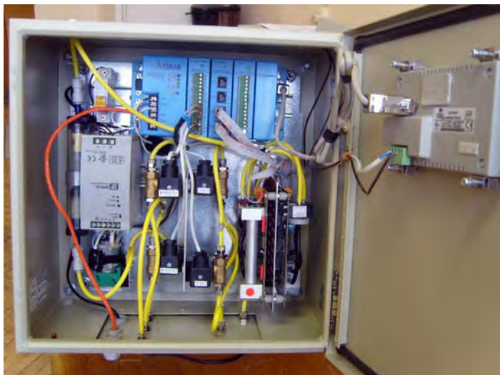
Общий вид шкафа управления с открытой лицевой панелью
