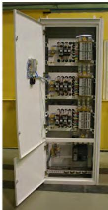
**Шкаф автоматической системы управления освещением птичников АСУ ОП «НИКА»**
