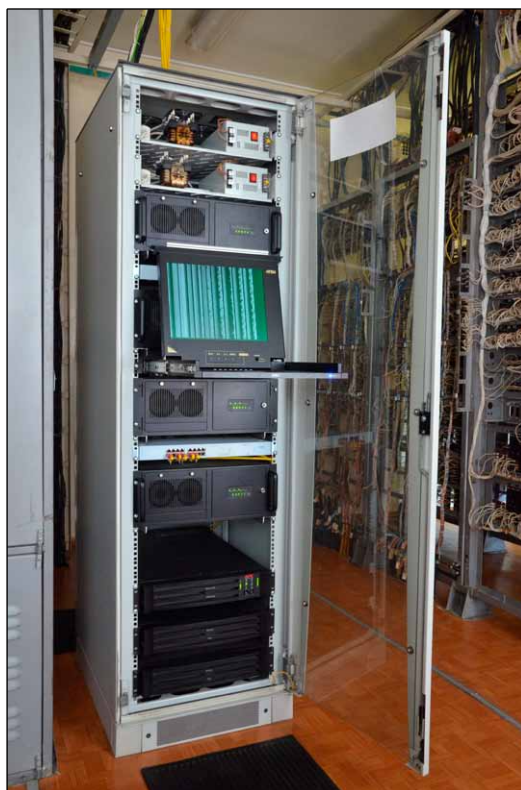
— Шкаф ядра системы Ипуть —
