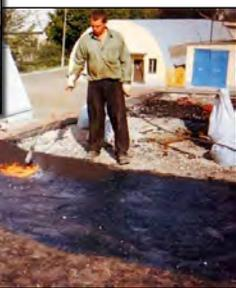
Нанесение битумного порошка на изолируемую конструкцию с расплавлением его газовой горелкой
