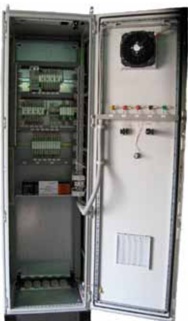
Программно-технический комплекс регистратор аварийных ситуаций (ПТК РАС)
