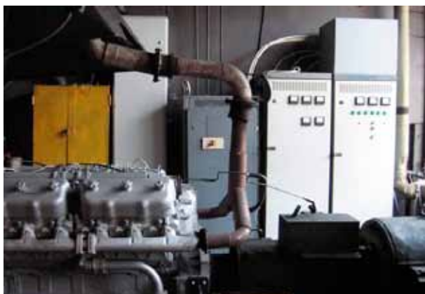
Испытательный стенд с рекуперацией энергии
