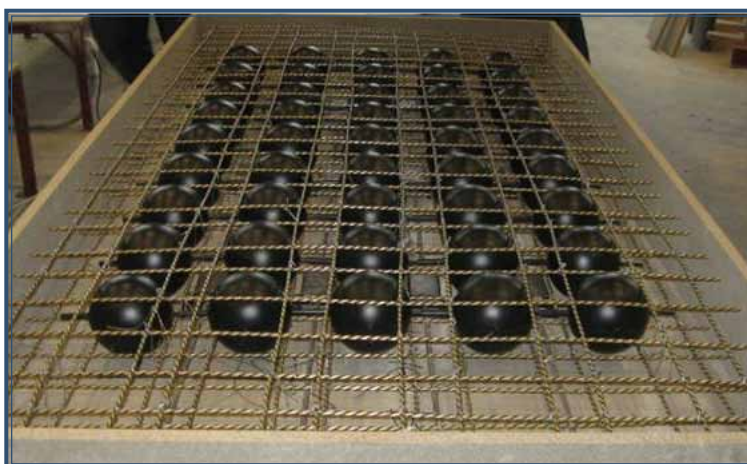
ЭФФЕКТИВНЫЕ МНОГОПУСТОТНЫЕ ДИСКИ ПЕРЕКРЫТИЯ
