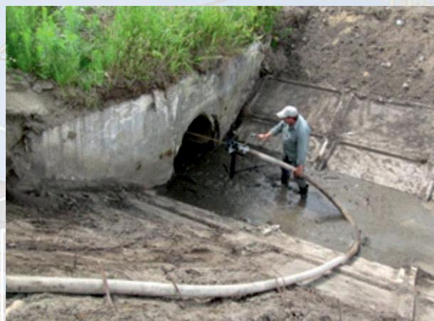
**Очистка отложений в полости трубы-переезда с применением установки УПТ-75**
