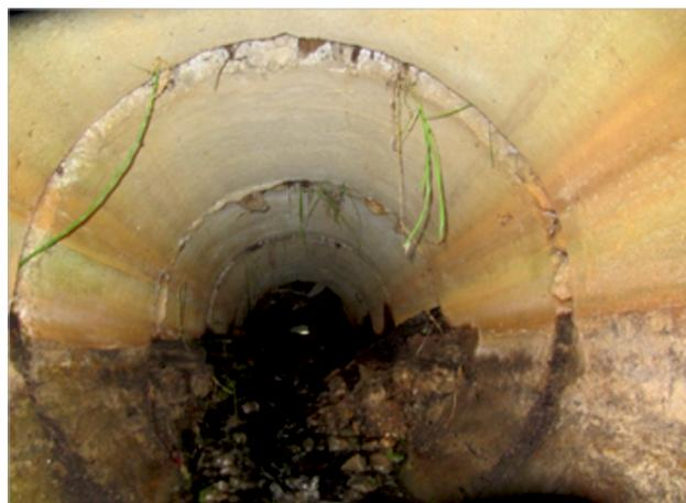
**Заиливание трубы-переезда с каменистыми включениями до ее очистки**
