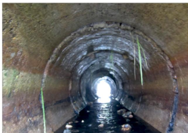
**Состояние трубы-переезда после ее очистки с применением установки УПТ-75**
