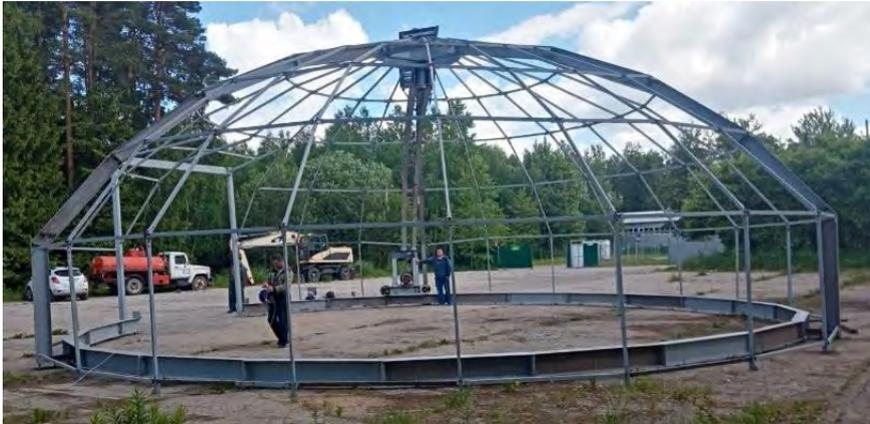
Многофункциональное мобильное сооружение с мостовым полярным краном
