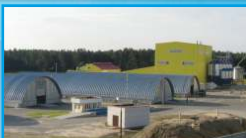
Склады для хранения зерна в ОАО «Комаровка» (Брестская область)
