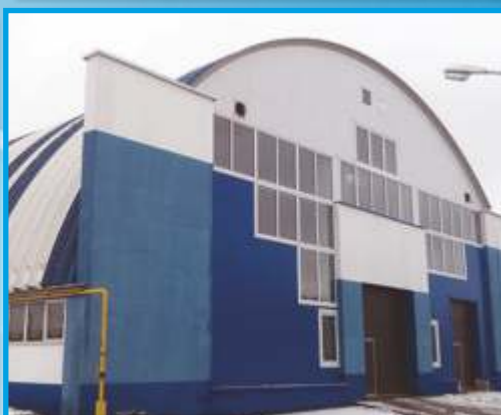
Механосборочный цех № 1 (г. Жодино, ул. Труда, 4)
