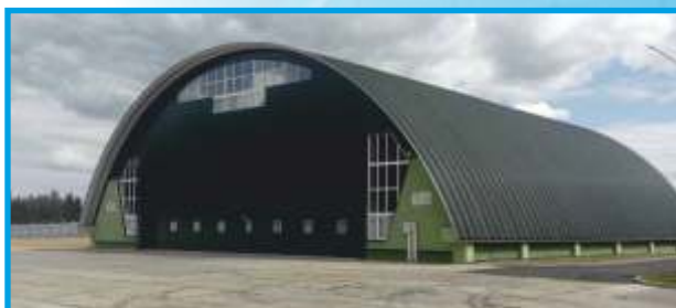
Склад № 2 на территории опытно-испытательной площадки (г. п. Мачулищи, Минская область)
