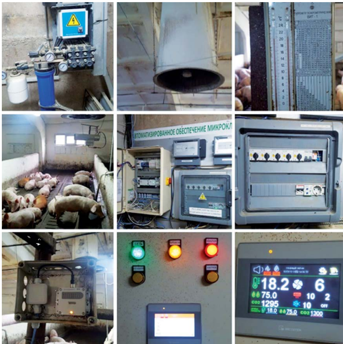
Рис. 113. Комплекты оборудования для диспетчеризации и поддержания микроклимата в автоматическом режиме в свиноводческих помещениях КОДМ
